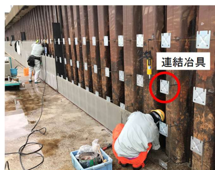
図1 パネル被覆工法の施工状況
